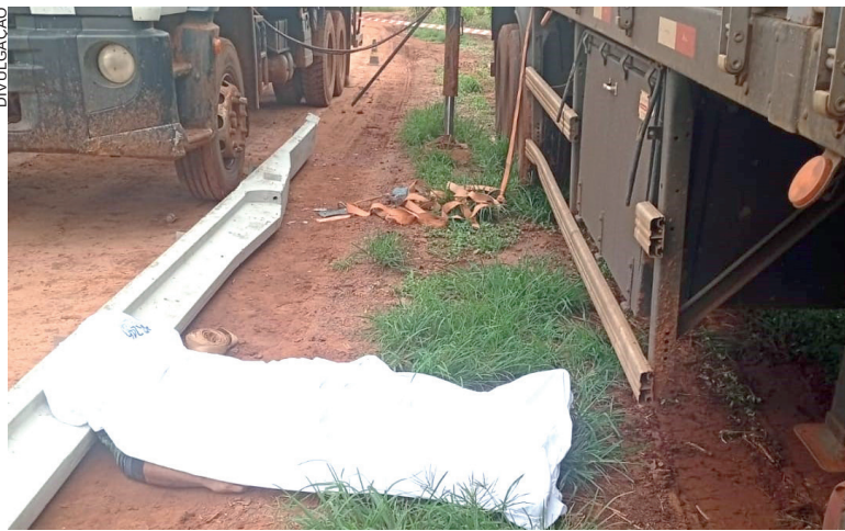
Trabalhador morreu depois que foi atingido na cabeça e no tórax pelas vigas de concreto
