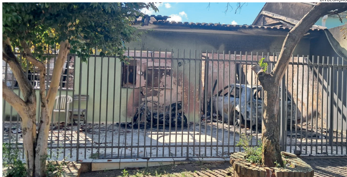
No dia seguinte, depois que as chamas foram contidas pelos bombeiros, foi verificado que a casa e os veículos foram completamente destruídos
