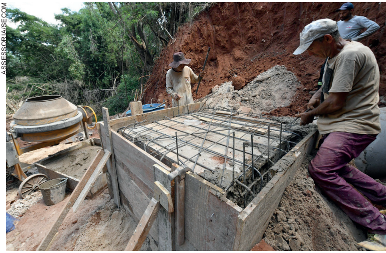
Após a preparação do terreno, foram instalados dois ramais de tubulação com grande capacidade de escoamento
