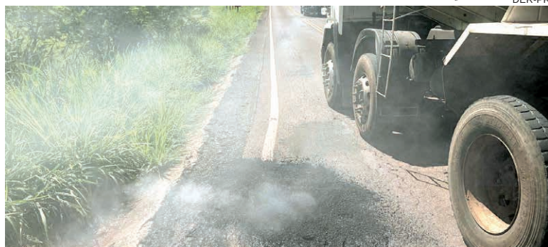
DER/PR começou os serviços na rodovia por meio de novo programa de manutenção e conservação. Outras intervenções maiores já estão sendo programadas
