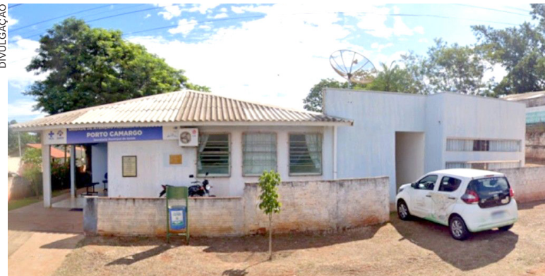
ENTRE os problemas encontrados estão rachaduras profundas, infiltrações, deficiências nas instalações elétricas e condições sanitárias consideradas inadequadas
