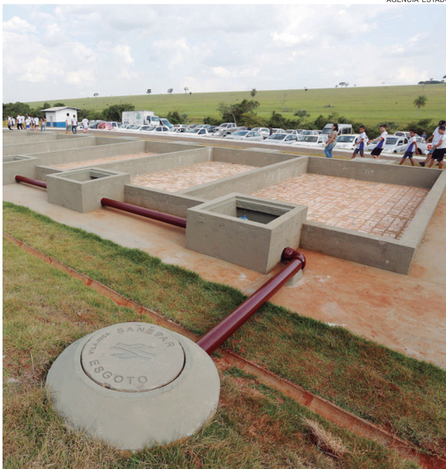
ESTAÇÃO de Tratamento de Edsgoto em Perobal
