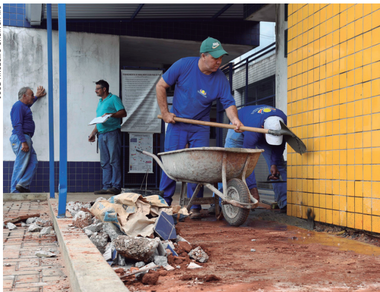
Equipes trabalham em reformas e melhorias dos estabelecimentos
