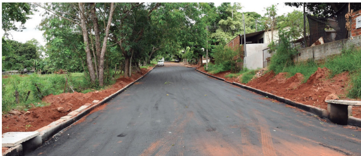
Pavimentação de vias feita com equipe da prefeitura
