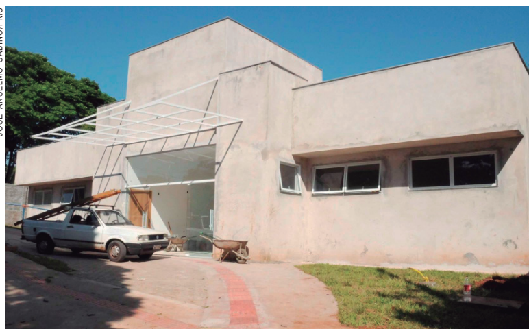
As obras de construção da UBS estão bem adiantadas
