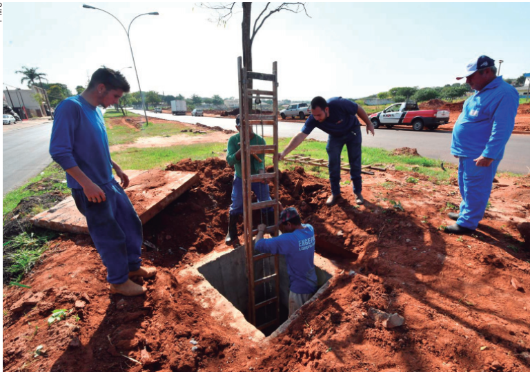
Trabalhadores entraram na tubulação para identificar os pontos que necessitam de reparos
