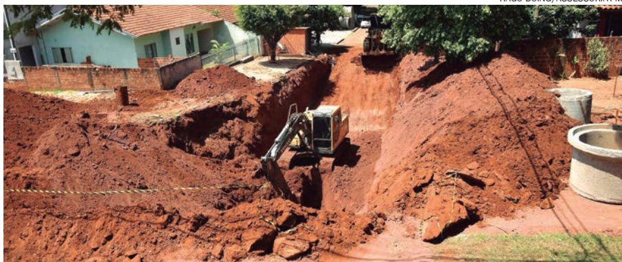
FORAM demolidas residências em imóveis desapropriados para a abertura de travessa, que fará a interligação das vias
