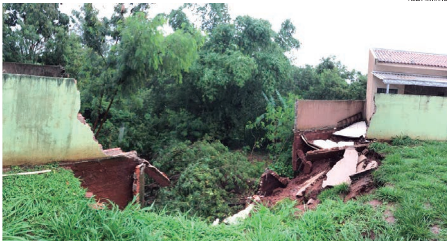
NUMA das casas atingidas, o muro foi engolido e na residência vizinha, a varanda foi levada morro abaixo
