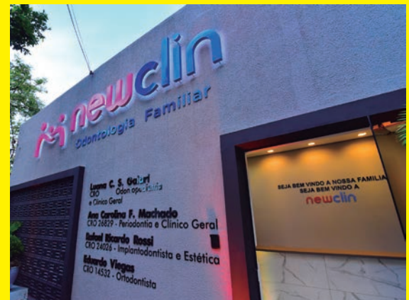
Fachada do novo espaço
