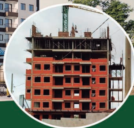
*Andamento da Obra TORRE A
