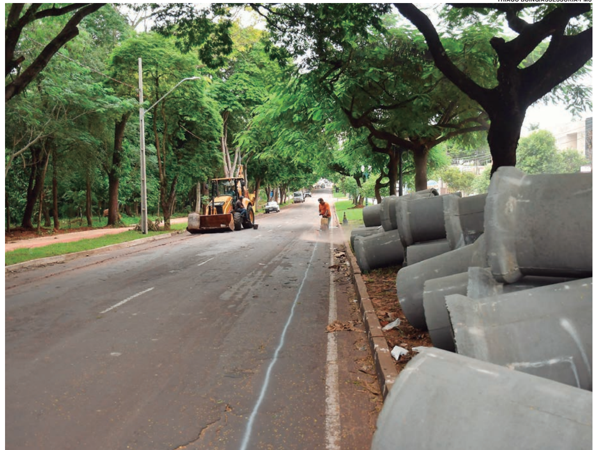
SERÃO 400 metros de rede dupla sob a pista, além de ramais em ruas e travessas cruzando o canteiro central captação de águas pluviais
