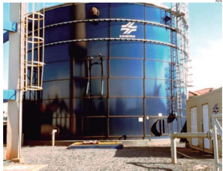
O novo reservatório tem capacidade para armazenar dois milhões de litros de água, aumentando em mais de 100% a capacidade de reserva
