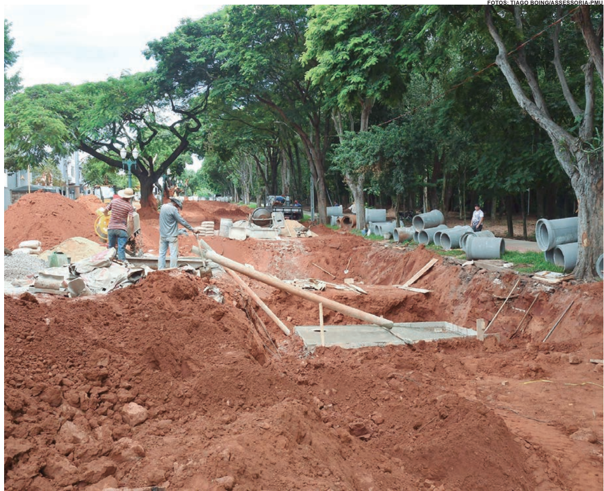
AS obras integram pacote de serviços de recapeamento e galerias que soma R$ 3.029.361,84, em recursos provenientes do governo do Estado
