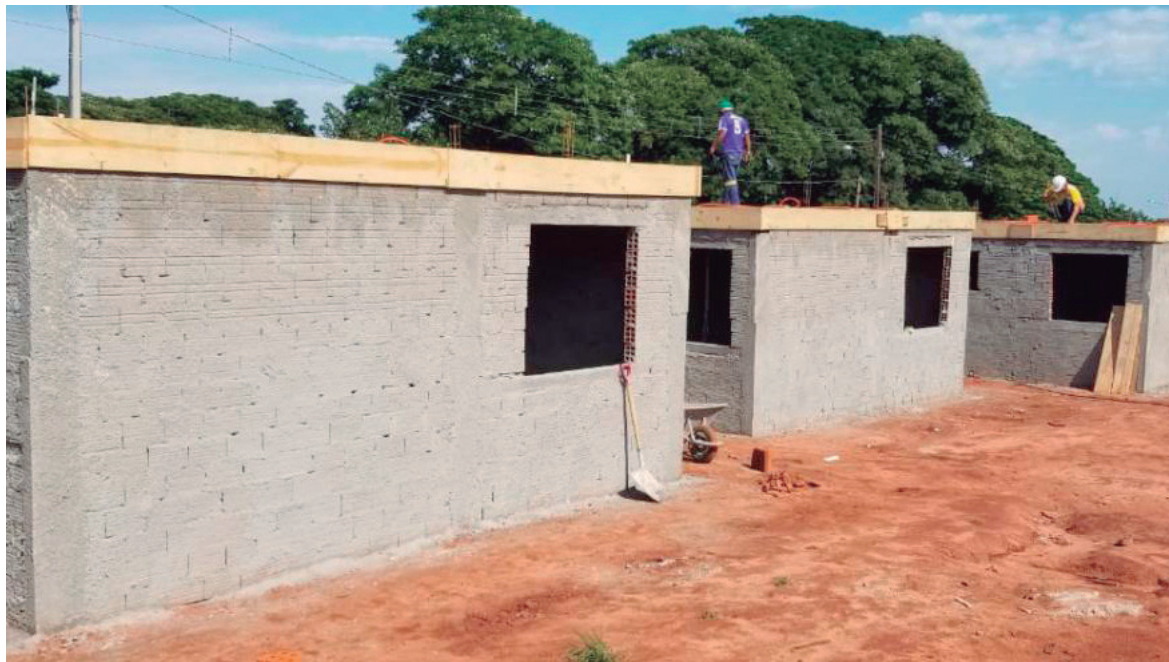
O empreendimento faz parte do programa Casa Fácil Paraná e está sendo executado pela construtora Implantec
