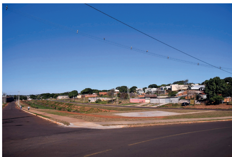
A OBRA tem cerca de 1.200 metros de calçamento entre o asfalto e a margem do riacho, que corre entre gabiões naquela localidade
