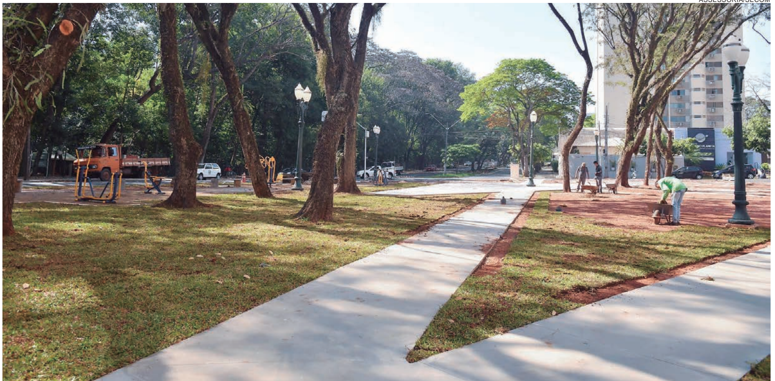
ALÉM de calçamento novo, a praça ganhará um novo espaço de passeio e lazer na parte central, com piso em concreto e bancos para os frequentadores
