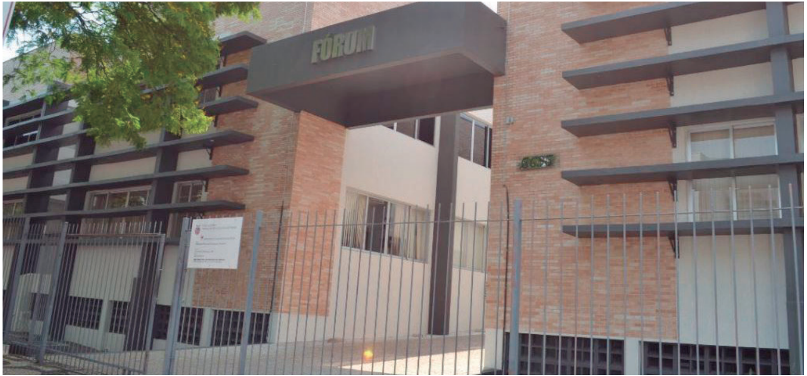
JULGAMENTO acontece 12 anos depois, no fórum de Umuarama e começa às 9h
