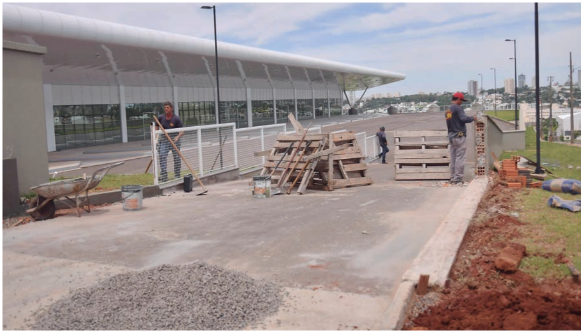
ALVENARIA e reposicionamento das bocas de lobo são realizados por mão de obra terceirizada e a pavimentação é executada pela Prefeitura
