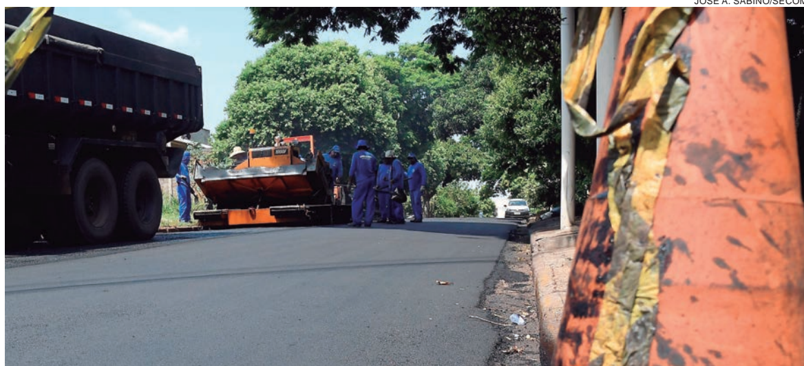
VÁRIAS ruas da Zona V foram contempladas em projetos de recape e execução será nos próximos meses, bem como acontecerá no Parque Dom Bosco
