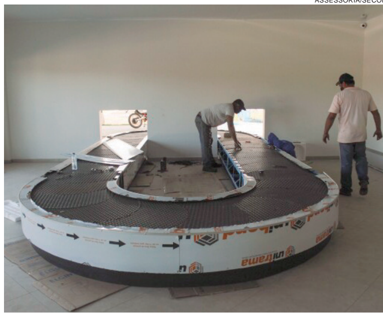
ESTEIRA instalada no Aeroporto Orlando de Carvalho em Umuarama foi uma das confeccionadas pela empresa
