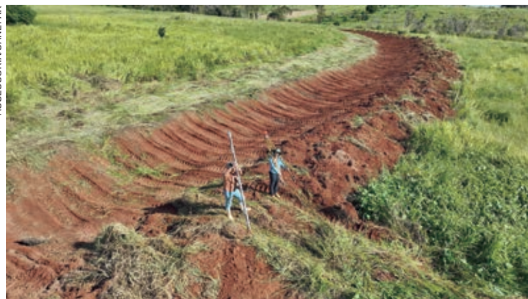
FORAM readequados 52 km de carreadores, feitos o cercamento em 4 km de área da APA e a estabilização de 1 km de encosta nas áreas de maior inclinação do terreno
