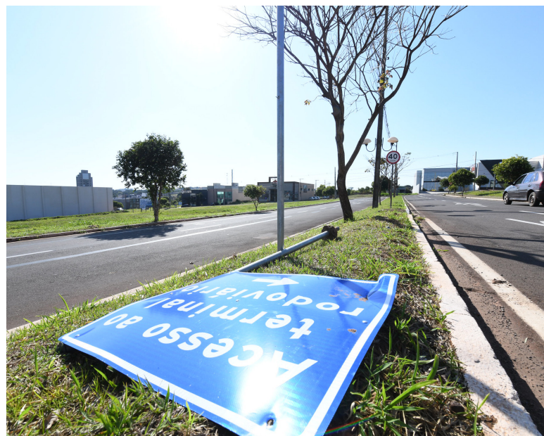
OS DANOS à sinalização vertical são mais recorrentes em vias de fluxo intenso de veículos no período noturno
