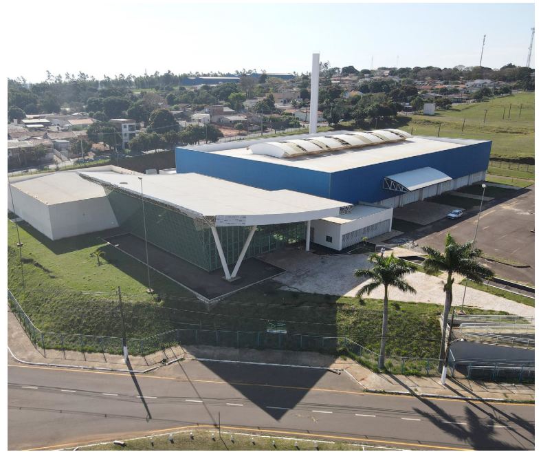
O MUNICÍPIO firmou contrato com a empresa que vai concluir o hall de entrada, a quarta e última etapa da obra do Centro de Eventos de Umuarama
