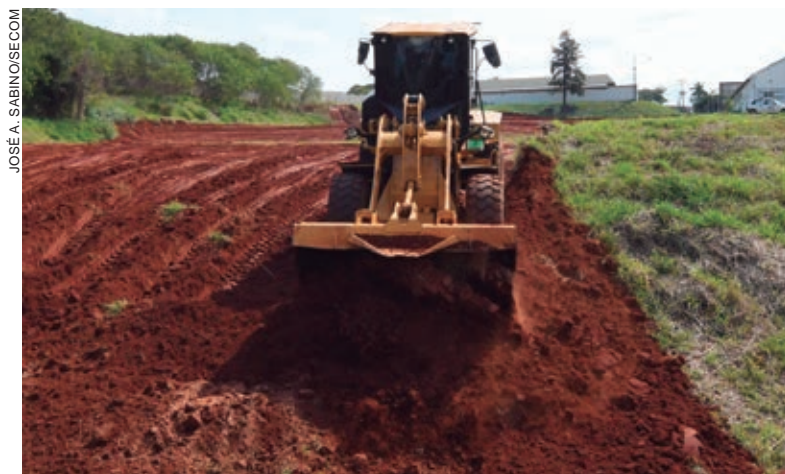
A terraplenagem foi iniciada na segunda e a próxima fase será a construção do muro. O projeto inclui também a construção de um gavetário para mais 500 sepulturas
