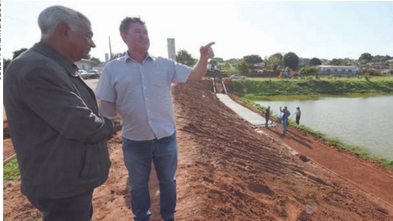
AS obras foram determinadas pelo prefeito Hermes Pimentel e encontram-se bem adiantadas. Nesta semana ele visitou o local
