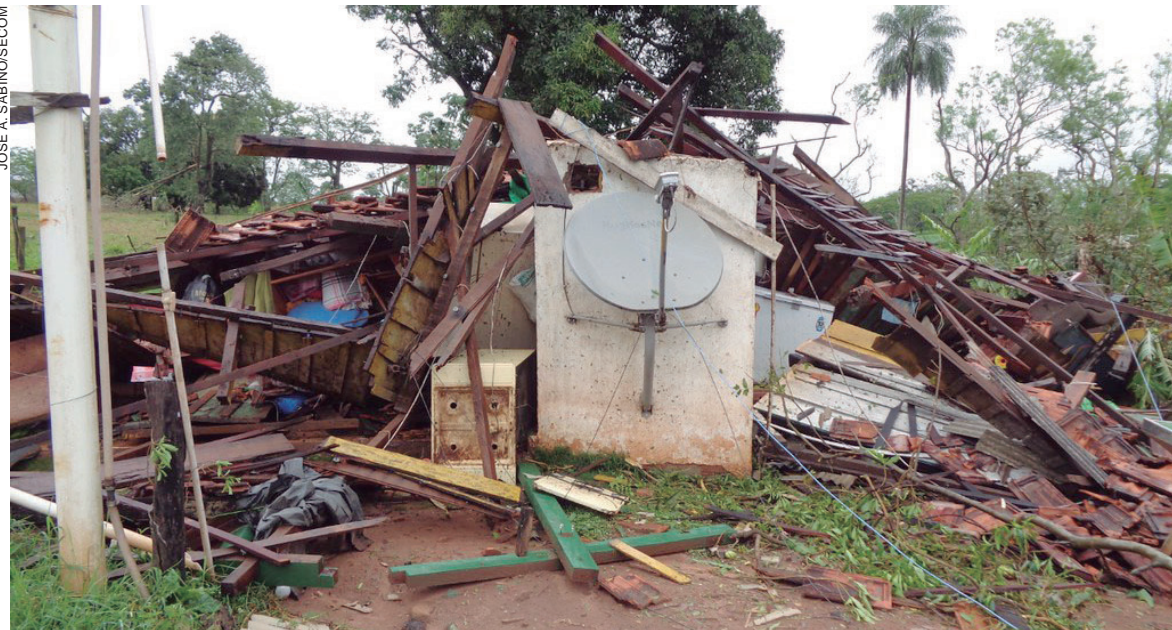
RESIDÊNCIA foi derrubada por inteiro em um dos distritos. Defesa Civil e Assistência Social acolheram moradores
