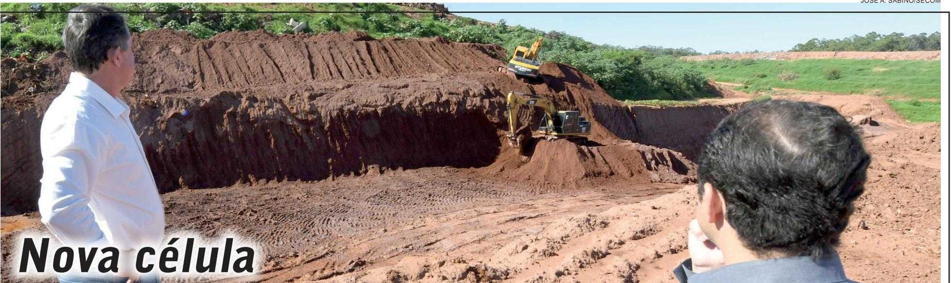
A Prefeitura de Umuarama iniciou a implantação de uma nova célula para receber resíduos volumosos no Aterro Sanitário. O espaço que já está sendo criado, terá capacidade para armazenar 52,5 mil metros cúbicos de resíduos com previsão de vida útil de três anos.
