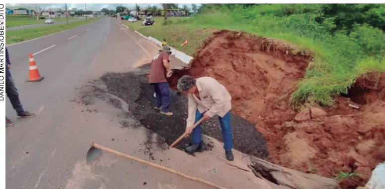
FUNCIONÁRIOS do DER deram início às obras para fechar a cratera que se formou devido ao grande fluxo pluvial que passa por baixo da rodovia PR-323
