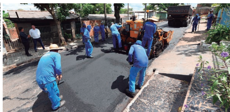
RORAM recuperados cerca de 6.000 m 2 de pavimento com massa asfáltica usinada a quente (CBUQ), onde houve um investimento de aproximadamente R$ 250 mil
