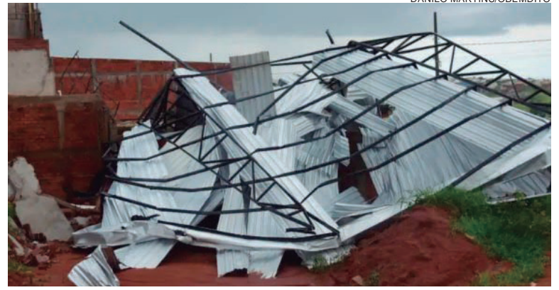
TELHADO de um barracão foi derrubado pela força do vendaval na tarde de ontem
