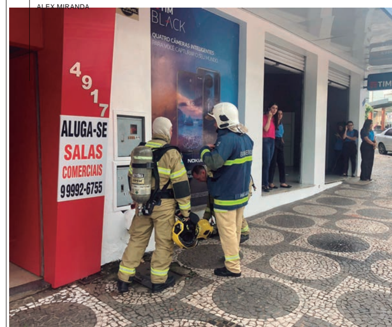
O Corpo de Bombeiros de Umuarama foi acionado na tarde de ontem (16) para conter um princípio de incêndio em uma revenda de celulares localizada na Praça Artur Thomas, no centro da cidade. O fogo teria sido iniciado na fiação do relógio de energia no lado de fora da empresa. Apesar do susto, ninguém ficou ferido. Esta é segunda vez, em poucos meses, que a empresa registra uma situação assim. Em dezembro, o Corpo de Bombeiros também atendeu a um chamado para controlar um princípio de incêndio dentro da loja.
