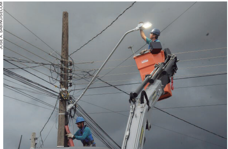
O investimento nesta etapa será de R$ 1.847.695,30 e prevê extensão de rede elétrica e substituição de 811 luminárias por LED
