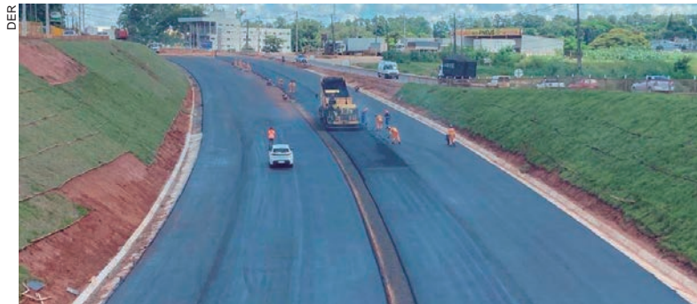
O trecho duplicado da PR-323 em Umuarama terá três novos viadutos, dois no trevo Gauchão e um no trevo para Mariluz
