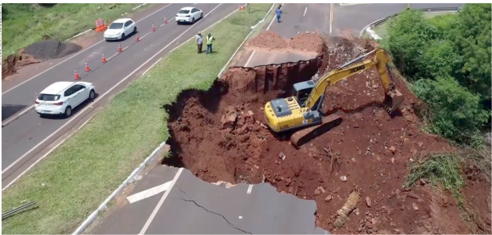
Escavadeira Hidráulica foi utilizada para ajustar o terreno que recebeu toneladas de pedras britas que foram esparramadas para segurar a erosão
