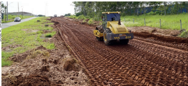
Correção e compactação do solo foram concluídas e, assim que estiver finalizada, será mais uma opção de rota para os visitantes da Expo Umuarama 2024
