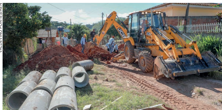
Projeto leva pavimentação às menores cidades e tem como um dos seus pilares o plantio de árvores para compensar a emissão de carbono decorrente das obras
