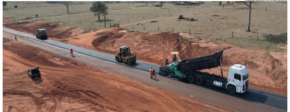
A empreiteira contratada para a obra praticamente finalizou a base, executa o agulhamento e, em paralelo, já aplica a camada de asfalto
