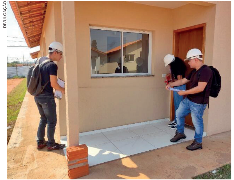
Em Umuarama, alunos de Engenharia da UEM vistoriaram obras no Jardim Pimentel, avaliadas em mais de 6 milhões e meio de reais
