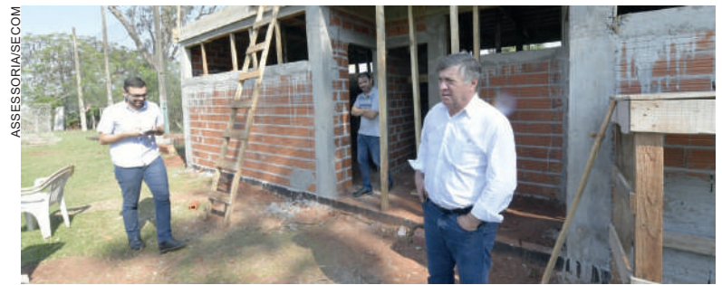
Pozzobom lembra que a administração municipal realizou diversas obras e serviços para melhorar a infraestrutura do distrito
