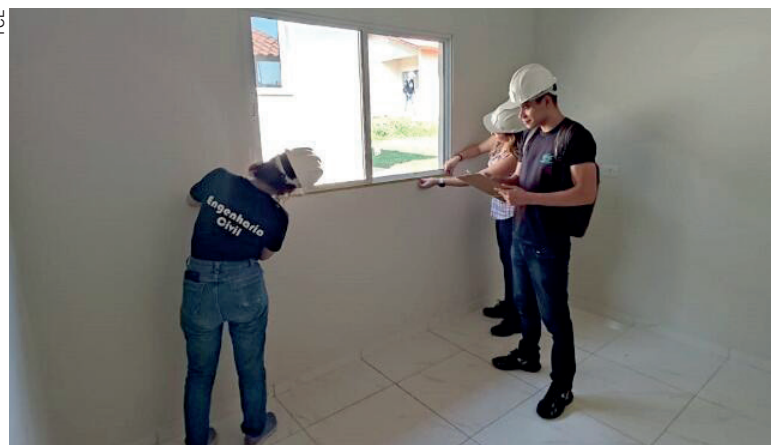
Em Umuarama, alunos das universidades estaduais vistoriaram as obras no conjunto habitacional do Jardim Pimentel
