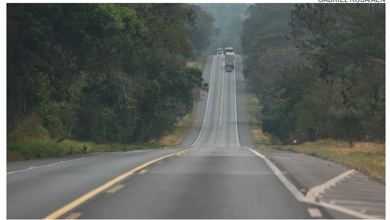
Lote 3 envolve 569 quilômetros das rodovias e, a partir de hoje (26) serão apresentadas as principais obras previstas nessa concessão
